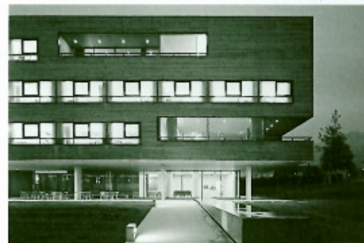
Altenpflegeheim Höchststraße in Dornbirn Standort Höchststraße 30 a, Dornbirn/A Bauherr Stadt Dornbirn, www.dornbirn.at Planung Johannes Kaufmann Architektur, Dornbirn/A, www.jkarch.at ; Riepl Riepl Architekten, Linz-Wien/A, www.rieppl.at Holzbau Fussenegger Holzbau GmbH, Dornbirn/A, www.fussenegger-holzbau.at Innenausbau Hase & Kramer, Dornbirn/A, www.hase-kramer.at ; Länge & Hagspiel GmbH & Co KG, Höchst/A, www.stuhl.at ; Meusburger Holzbau, Lauterach/A; Weiler Möbel Tischlerei GmbH & Co KG, Weiler/A, www.weilermoebel.at Fertigstellung 2005
