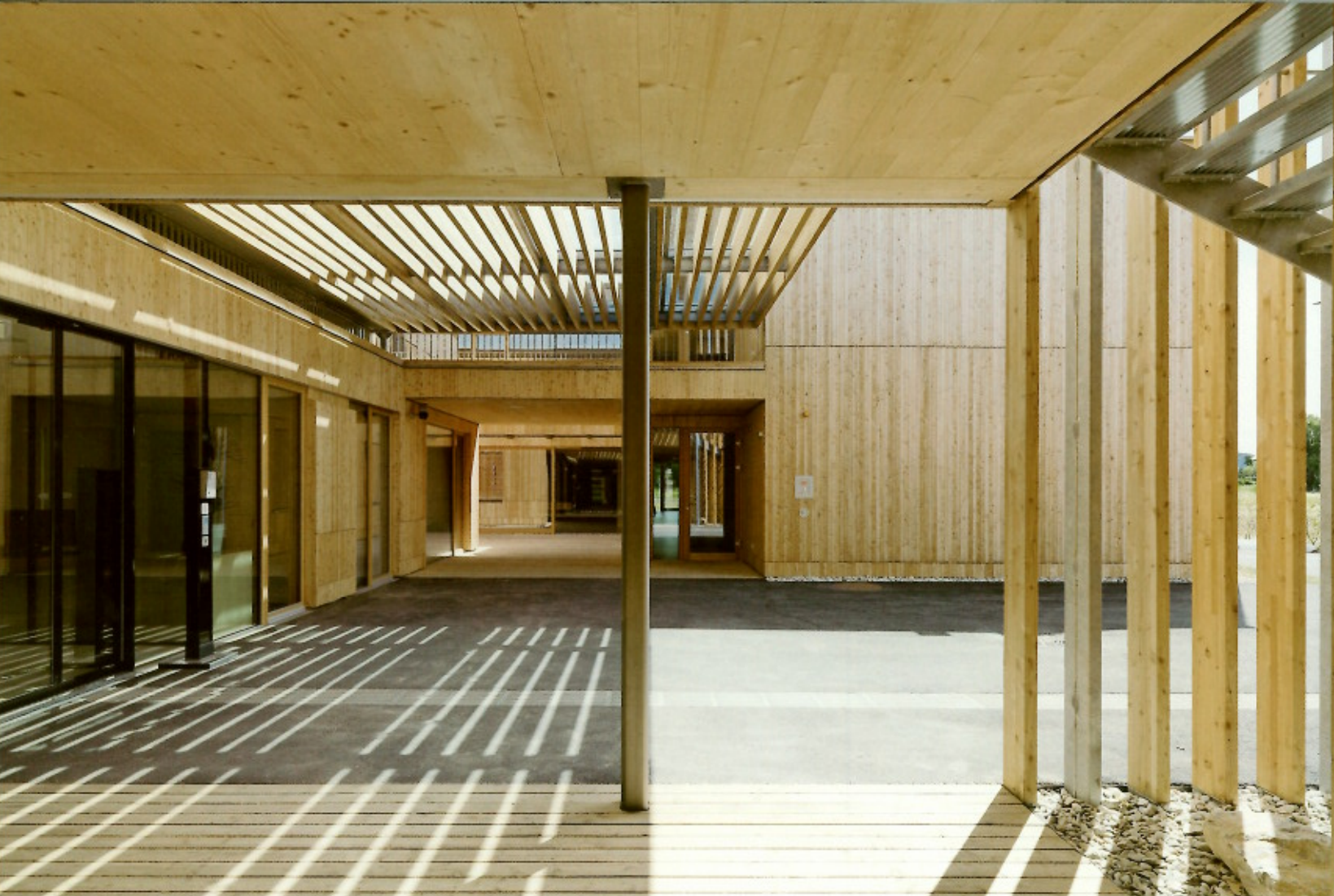
图4 以交错层积木材作为承重结构的墙体和顶棚
